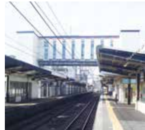
▲エレベーター全体
