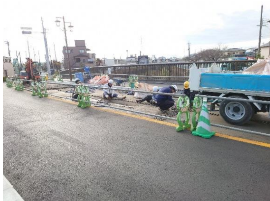
構造物取り壊し
