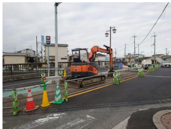
花壇上重機設置状況
