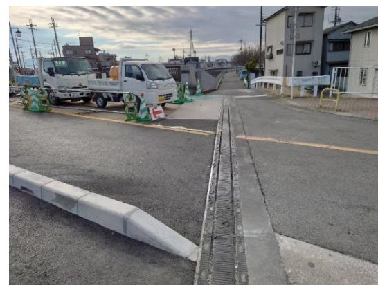
伸縮装置全景
