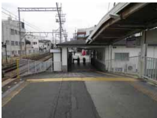
構内スロープ（布忍駅）
