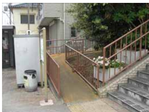
構外スロープ（高見ノ里駅）
