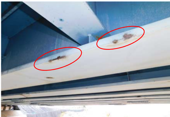
■ 鋼材の腐食
