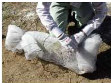
・運搬前の伐採木の被覆 伐採木を防風ネット又はビニールシートで覆って飛散防止措置をした上で運搬する。
