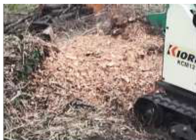
・伐採木の破碎 伐採木をチップパーなどを用いて、厚さ10mm以下を目安としてチップ化する。
