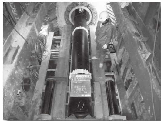
耐震管への更新工事のようす
