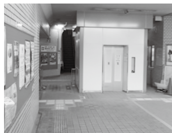
▶工事中の状況(地下)
