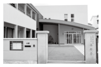
本行寺新本堂(東新町3丁目)平成24年、旧本堂が建て替えられて一新された。
