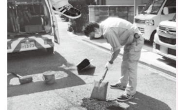
▲現場に出て道路の補修作業を行っている様子。
