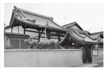
▲安養寺(阿保6丁目) 山門は平成6年の改築だが、そのもとは明治24年(1891)4月、三宅村の大工の岡本長三郎、岡本吉平が建てたもの。
