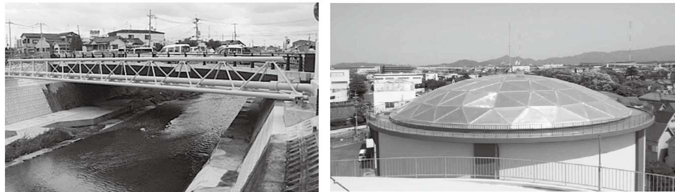
▲西除川にかかる水道管用の橋(水管橋)
