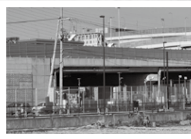
▲三宅西遺跡を南からのぞむ (三宅西7丁目) 三宅西ランプの高架下に弥生集落が広がっていた。
