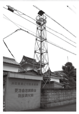
称名寺横にある更池特設消火班の火の見やぐら (南新町二丁目)
