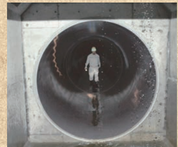
▲雨水管内部の様子 大阪中央環状線に敷設されている内径2.0mの雨水管内部の様子
