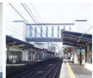
▲エレベーター全体
