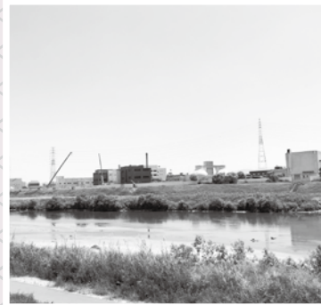
▲「依網池址」石碑の南側の大和川土堤から天美西の今池水みらいセンターをのぞむ
