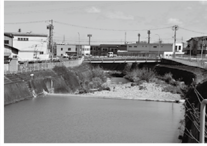
▲西除橋・丹南橋間に設置された河合井堰 (岡7丁目・野遠町) 奥が西除橋
