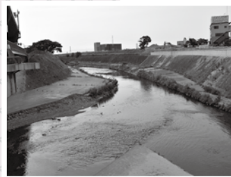
▲東除川(左手前)・落堀川(右)合流点から西へ流れる東除川放水路(大堀4丁目)
