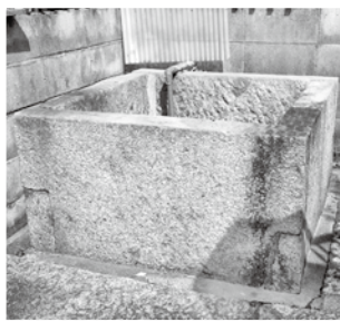
▲改修前の「高見の惣井戸」西側から。平成20年代。
