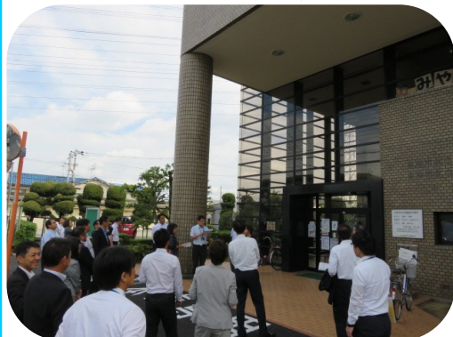
三宅公民館外壁等改修事業
