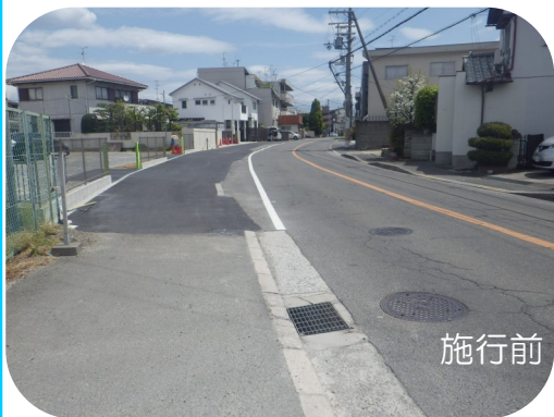
新堂南線歩道整備事業
