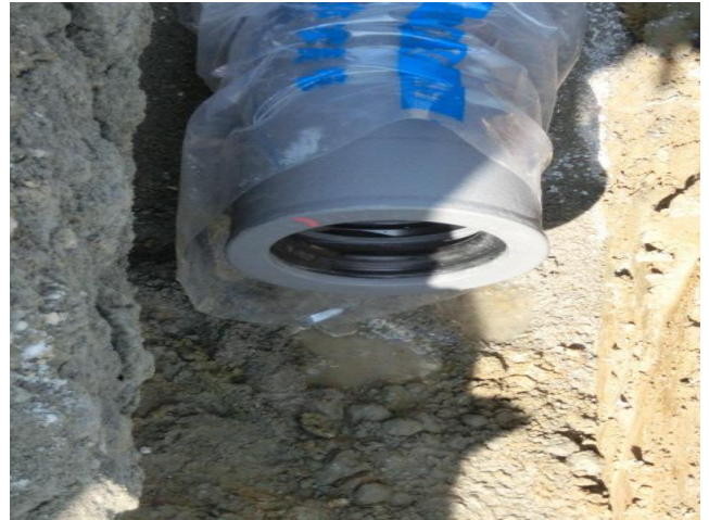
ダクタイル鋳鉄管(φ150mm) 布設状況
