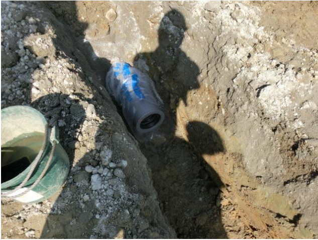
ダクタイル鋳鉄管(φ150mm) 布設状況
