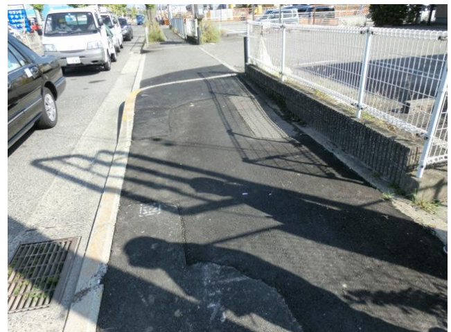
仮配管布設工(φ75mm) 施工完了
