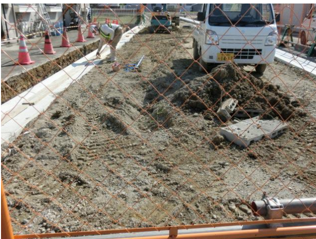
ポリエチレン管(φ50mm) 施工完了
