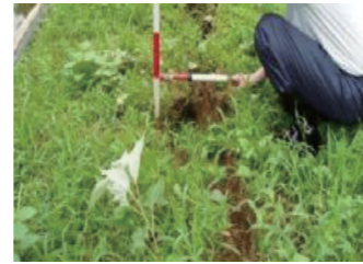
堤体の亀裂に注意
