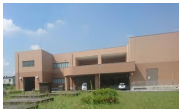
写真 2.3.4 松原ポンプ場（松原市施設分）
