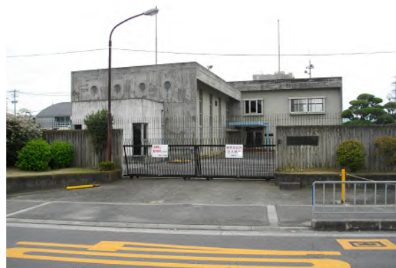
写真 2.3.3 天美我堂配水場
