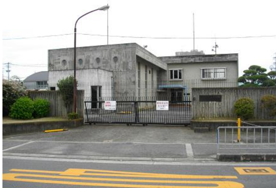
写真 2.3.3 天美我堂配水場
