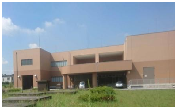
写真 2.3.4 松原ポンプ場（松原市施設分）
