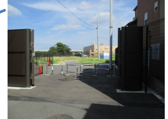
松原ポンプ場「水の広場」
