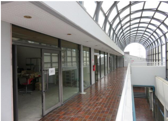
・ F棟3階通路西向き
