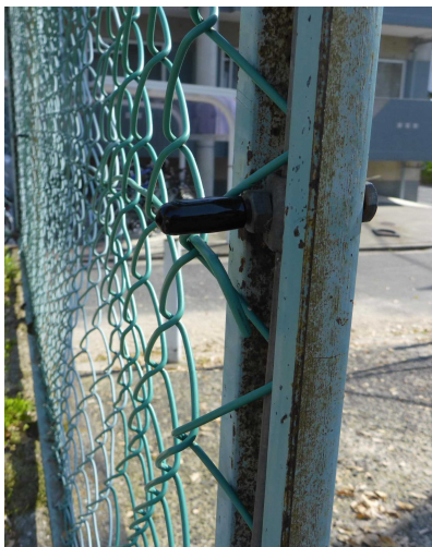
ボルト応急処置状況
