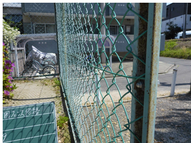
ボルト処置後
