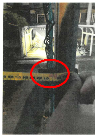
ボルト突出状況
