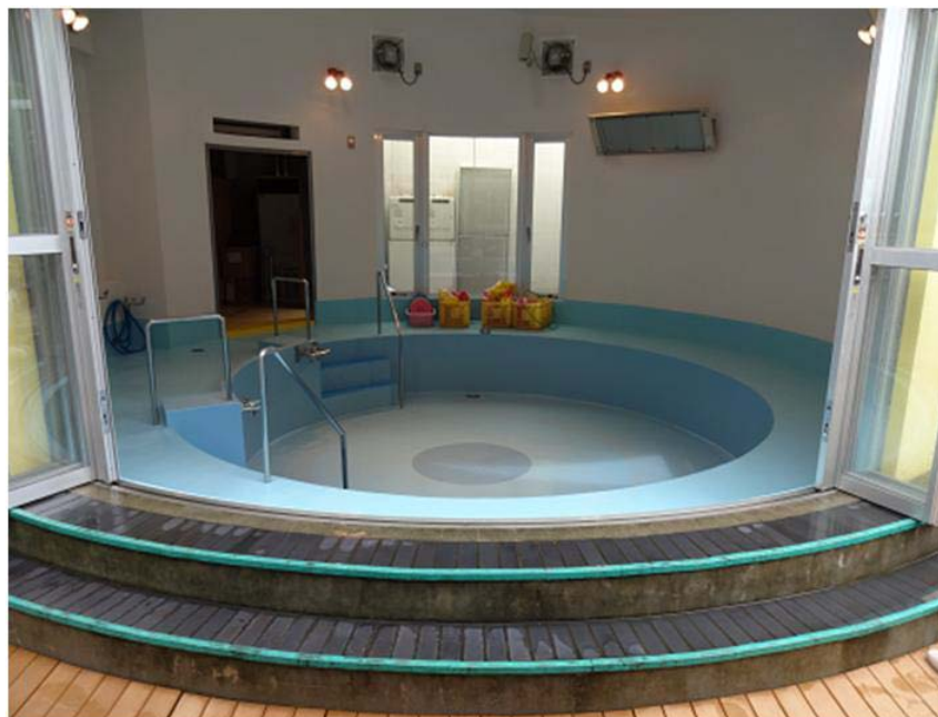
写真1 当該幼稚園のプール室
