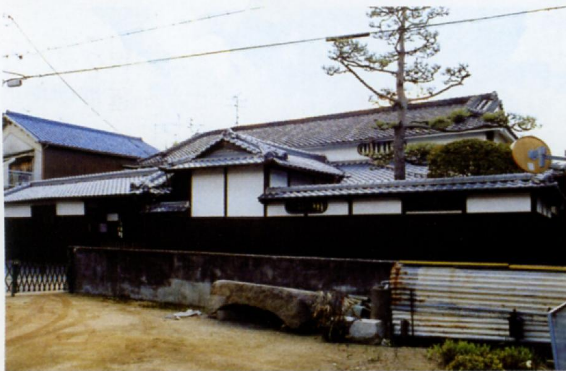
▲正面外観（北より望む）
