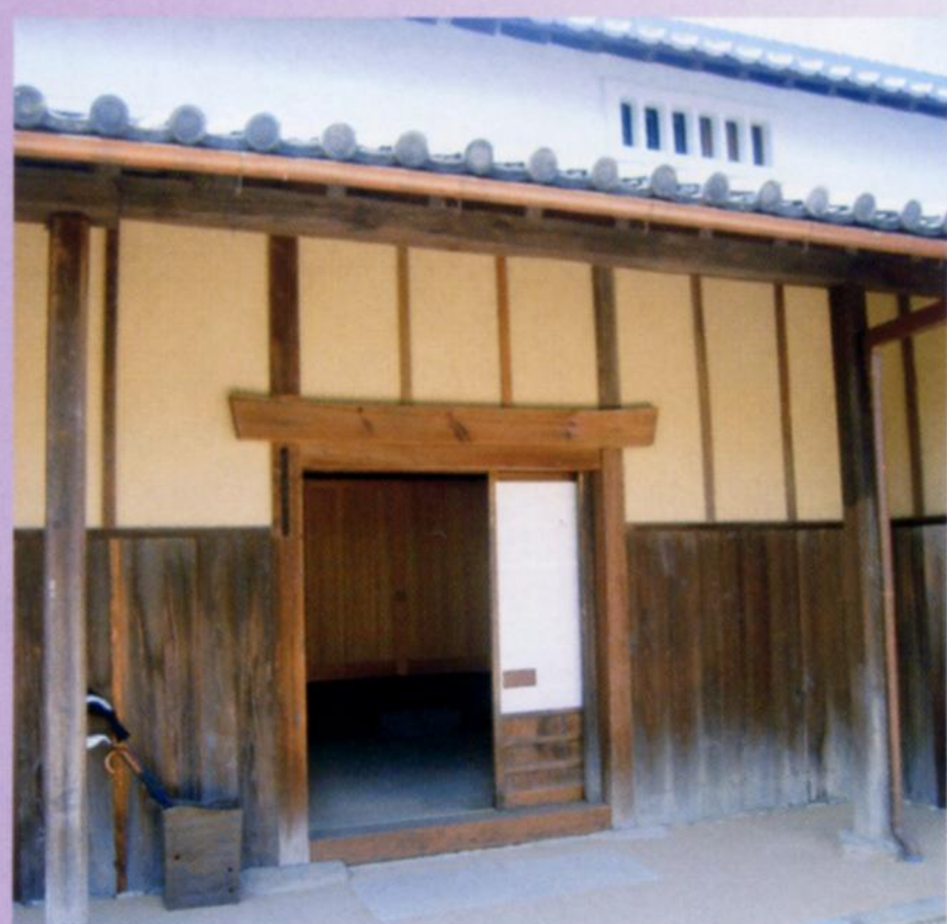
大戸口 普段の土間出入口
