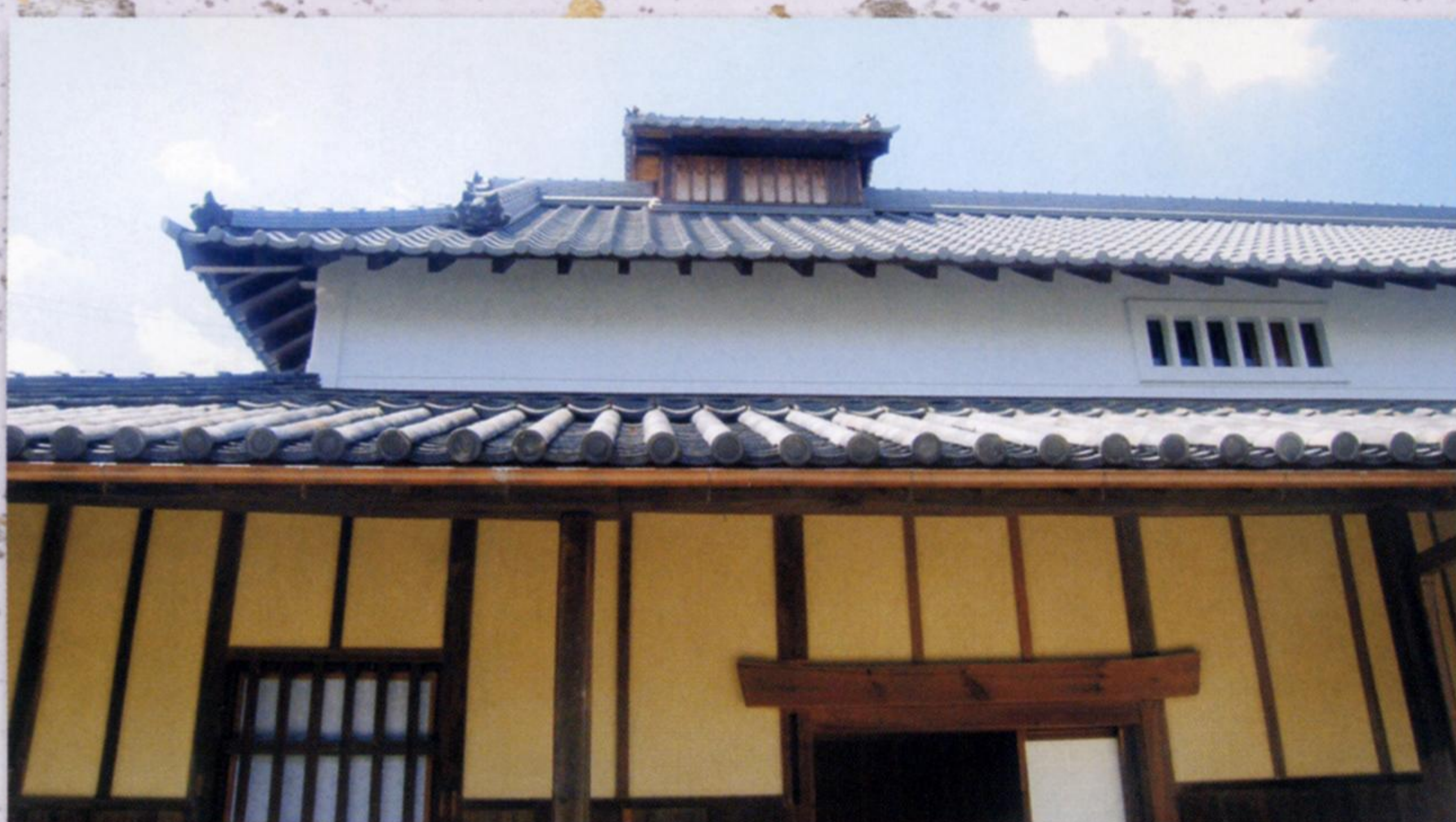
主屋北側正面の外観 大戸口付近から屋根の煙出しを見る
