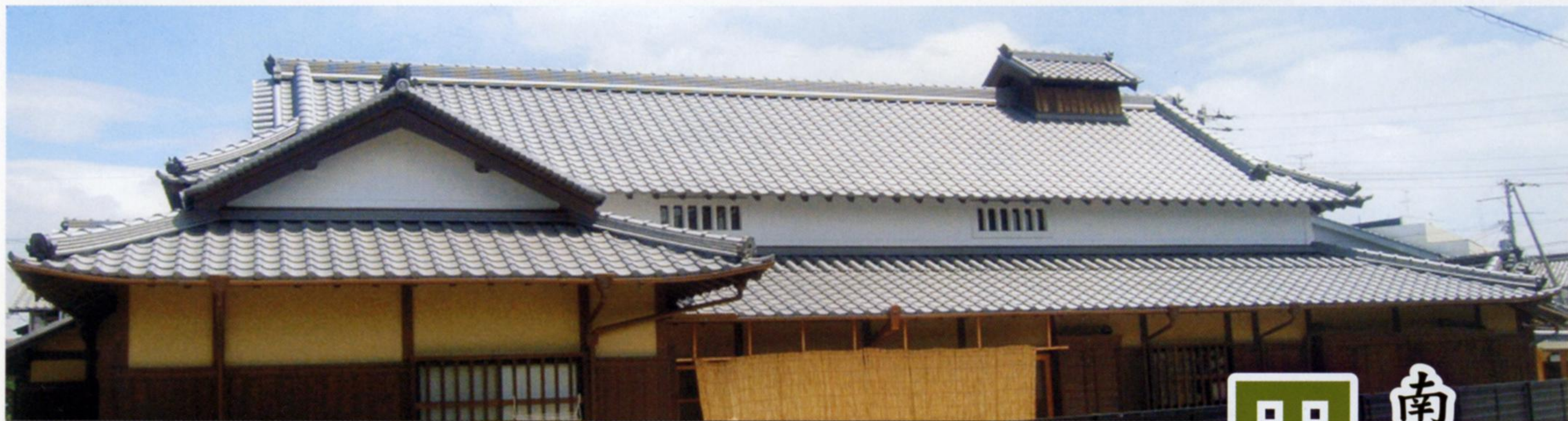
主屋南側の外観
