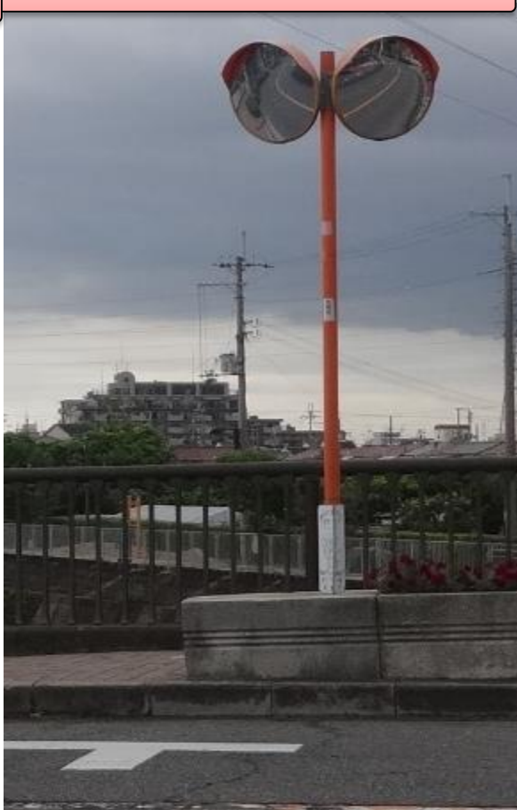
カーブミラーの整備
