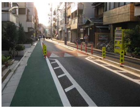
写真Ⅱ-12 車道部分にハンプを設置しハンプの両側にゴム製ポールを設置した事例
