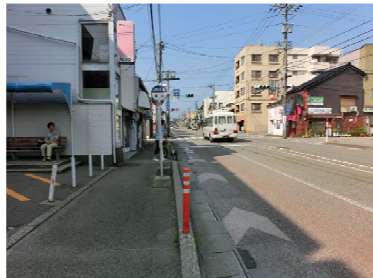
写真Ⅱ-10 バス専用通行帯を活用し路面表示を設置した事例
