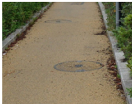
写真Ⅱ-3 マンホールの蓋に滑り止め加工している事例
