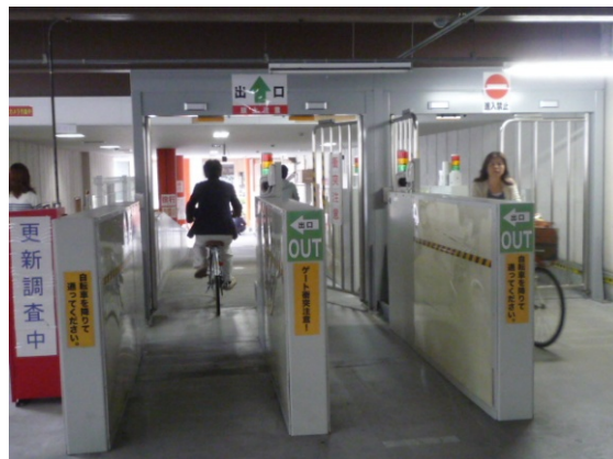
事例IV-8 ICタグを利用しノンストップ自動ゲート付駐輪場を整備した事例
