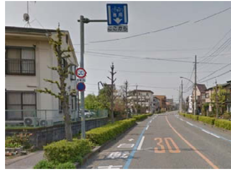
写真 I-3 自転車専用通行帯の事例 (幅の一部をカラー化)
