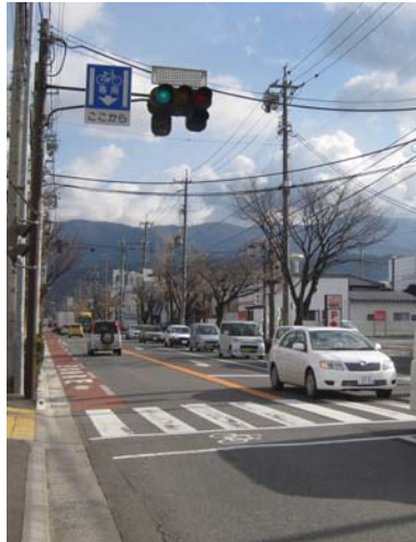
写真Ⅱ-6 道路標識「専用通行帯(327の4)」と道路標示「専用通行帯(109の6)」を設置した事例
