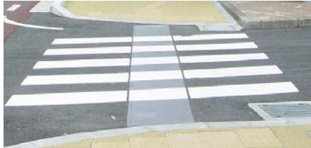
写真Ⅱ-14 横断歩道におけるエスコートゾーンの設置例
