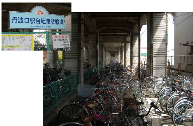
事例Ⅳ-5 鉄道事業者と協力し鉄道高架下に駐輪場を整備した事例
