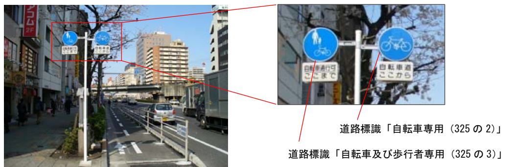
写真Ⅱ-4 道路標識「自転車専用（325の2）」を設置した事例 （標識の下に自転車道の起点を示す補助標識を設置）
