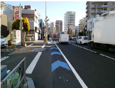
写真 I-4 車道左側部の路肩内に矢羽根型の路面表示を設置した事例
