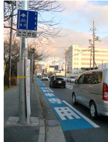
写真Ⅱ-7 道路標識「普通自転車専用通行帯(327の4の2)」と道路標示「専用通行帯(109の6)」を設置した事例
