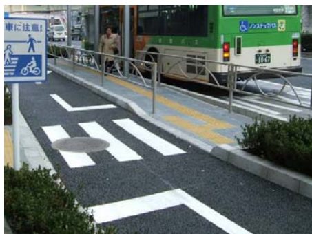
写真Ⅱ-5 停止線を設置した事例
