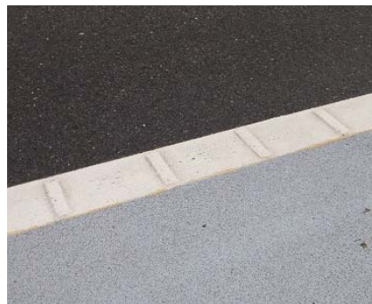
写真Ⅱ-8 道路標示「車両通行帯」を凹凸のついた仕様とした事例
