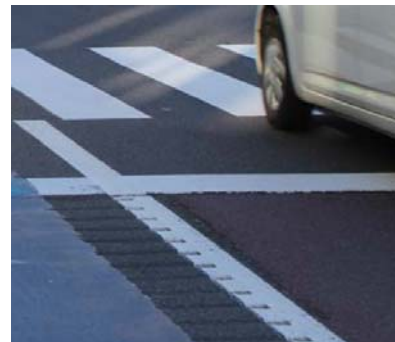
写真Ⅱ-8 道路標示「車両通行帯」を凹凸のついた仕様とした事例
