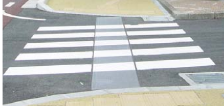
写真Ⅱ-14 横断歩道におけるエスコートゾーンの設置例
