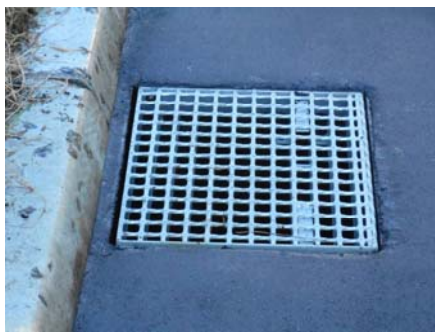
写真Ⅱ-2 グレーチング蓋の格子の形状等を工夫した事例
