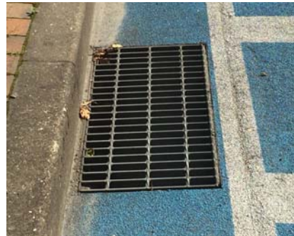
写真Ⅱ-2 グレーチング蓋の格子の形状等を工夫した事例
