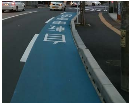
写真Ⅱ-1 街渠をエプロン幅の狭い平坦性の高いものに置き換えた事例
