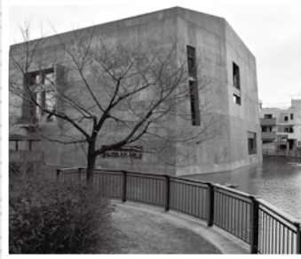
▲北東の今池親水公園ごしに外観をのぞむ(田井城3丁目・今池) 西側の窓からは、午後になると、池に反射して揺らぐ太陽の光が天井に映る。
