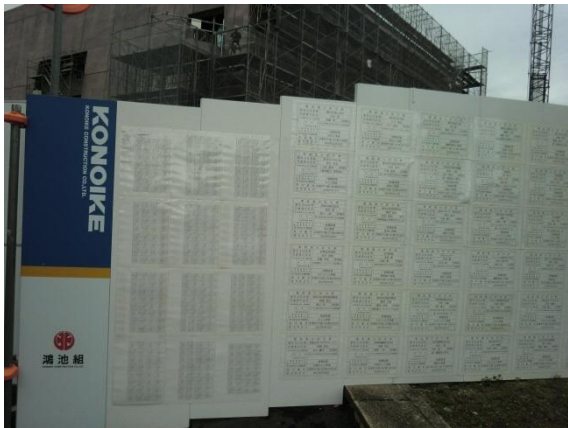
仮囲い外面 建設業許可票等掲示状況
