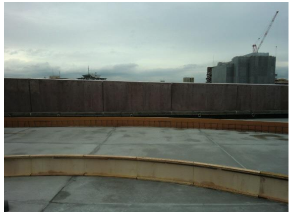
屋上 押さえコンクリート、植栽部施工状況
