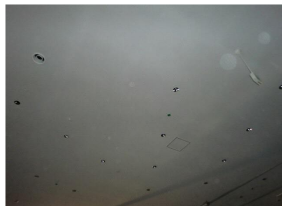
天井面 吹付用軽量塗装仕上
